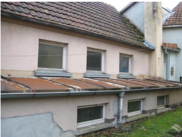
Rückseite der alten Schule hinter der Kirche
