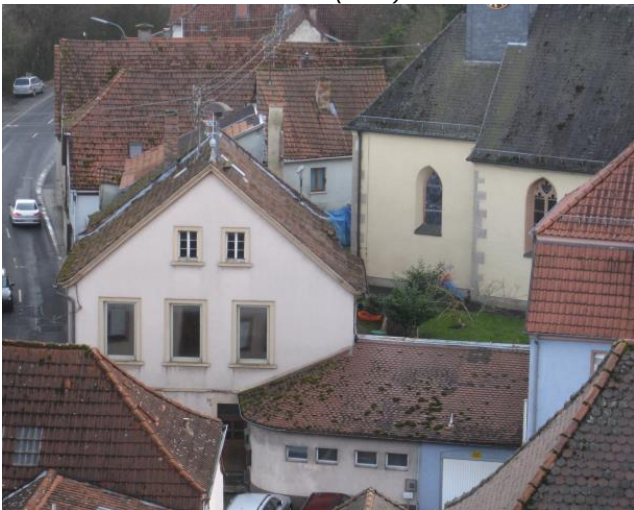
2016: Ensemble zwischen Schule und Kirche mit Hof und früherer Wohnhausteil Freibert-Rudolf
